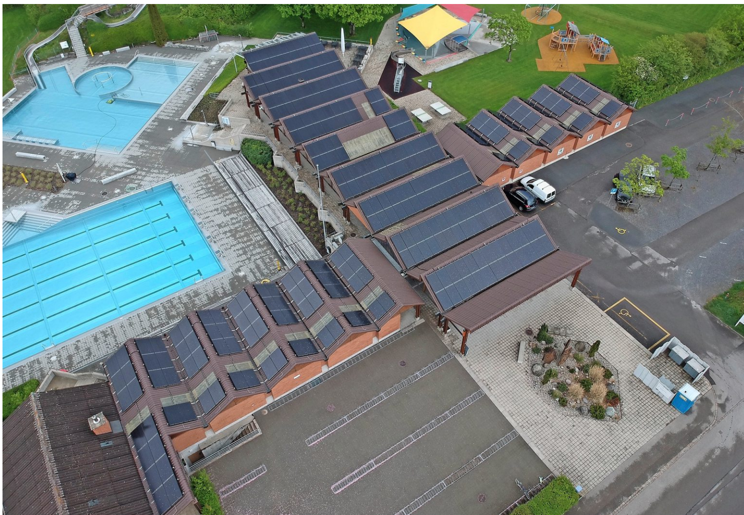
Die Badi Seuzach von oben: Grosse Dachflächen, die in verschiedene Himmelsrichtungen zeigen, begünstigen die Stromproduktion. Foto: PD
