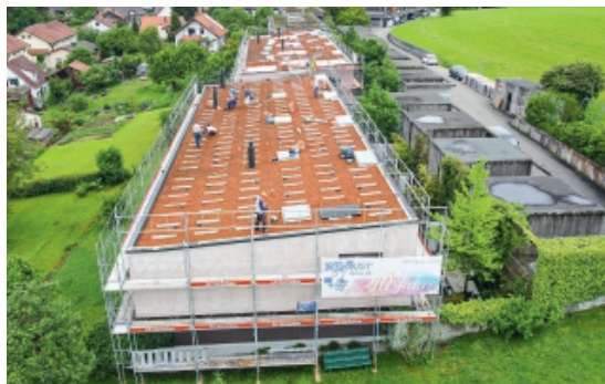
Blick aus der Vogelperspektive: Die «PV-Gemeinschaft Roos» im Einsatz auf dem Dach ihrer Gebäude
