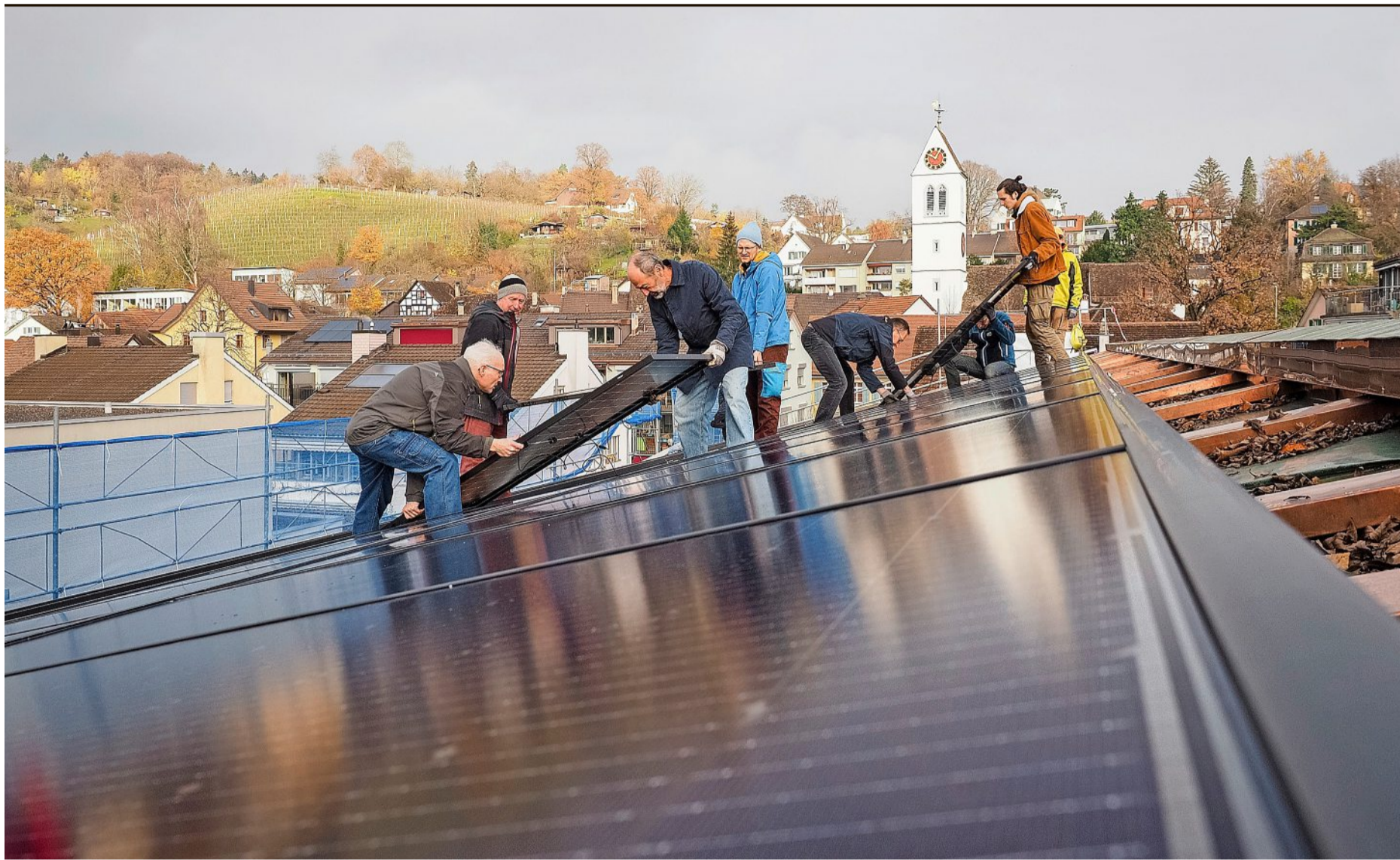
Der letzte Puzzlestein: Freiwillige und Genossenschaffer verlegen auf dem Dach des Kirchgemeindehauses Veltheim die Module der neuen Solaranlage. Fotos: Enzo Lopardo
