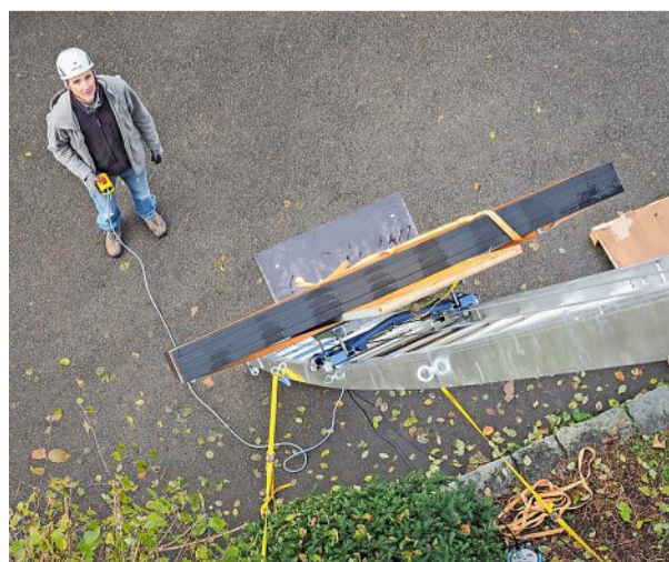
Gerald Jödicke von der Kirchgemeinde bündelt vier Module und schickt sie per Lift nach oben aufs Dach.
